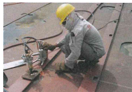
Esempio di applicazione in cantiere navale
