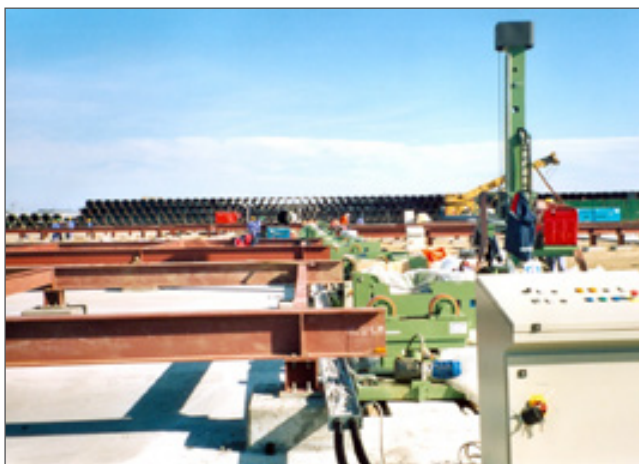
BTC (Baku>Tiblisi>Cheyang) pipeline: cantiere «doppio giunto» di Yevlah Camp - Azerbaijan
