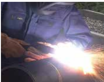
Rimozione della saldatura
